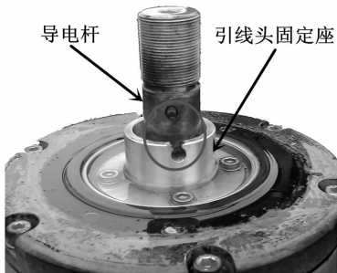
a) A 相套管拆开将军帽后引线接头图
