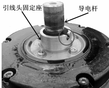
b) B 相套管拆开将军帽后引线接头图
