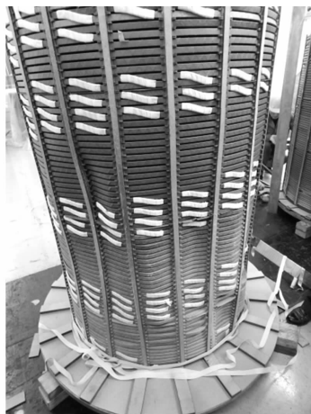
图8 吊心检查中压B相
