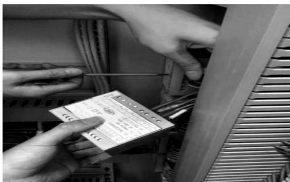
图 9 更换电压采集模块现场照片
