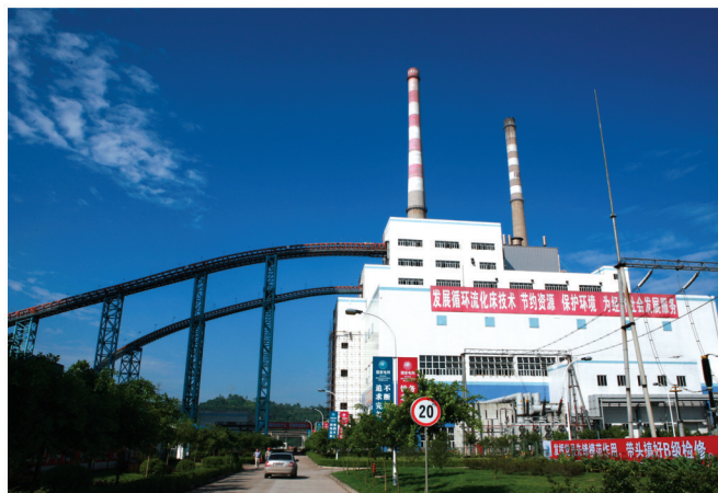
四川白马 1 \times 300 MW循环流化床示范电站工程
