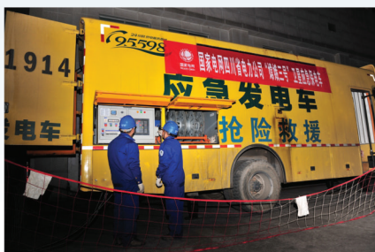
2014年12月2日，公司圆满完成“嫦娥三号”卫星发射保电工作
