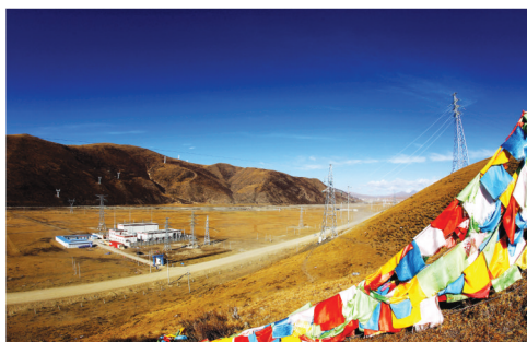
“电力天路”工程全面完成
