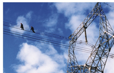
依法质监：质监人员爬上 新甘石线路铁塔
