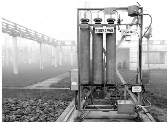
图 3 微水在线控制系统现场图
