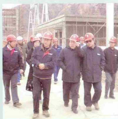
省公司王抒祥总经理视察新都桥变电站
