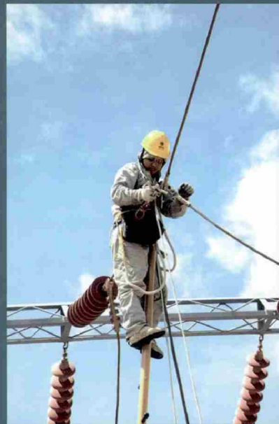
变电站带电断、搭引流线2
