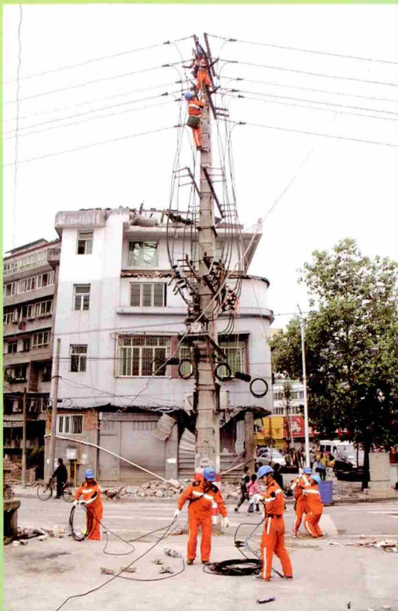
“4.20”芦山地震后，德阳供电公司紧急驰援灾区。图为电力员工正在恢复芦山城区低压线路。
