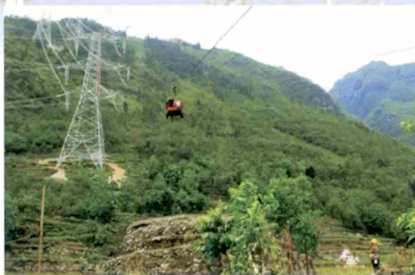
四川送变电公司针对高山、高落差、放线段长、过滑车次数多的特殊外部条件，为保证顺利开展架线工程，保护导线放线质量，研发出组合式山区重型索道在500kV锦乐线将重达5.1t的大型施工器具张力机从山底运输到山顶的指定位置。首次在高山大岭地区张力场“上山”。
