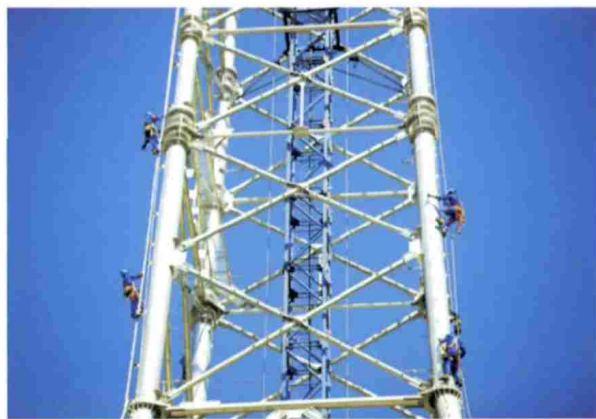
中国第一条特高压1000kV淮上线正紧张建设，平均170m的特高压铁塔施工给送变电员工带来极大挑战，四川电力送变电建设公司攻克了一项项世界施工难题。图为施工人员正上塔施工作业。
