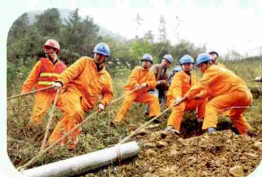
220 kV变电站集中检修
