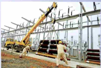
新建变电站施工
