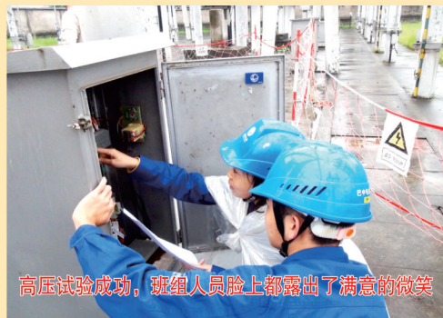
新放电缆有序接入机构箱
