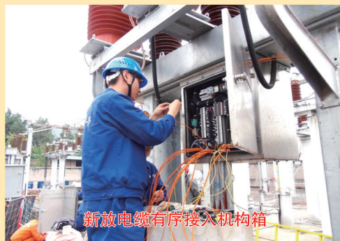
王堂站无油化改造时110kV线路CT介损损耗试验
