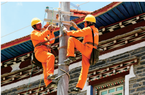
电力员工在抢修现场
