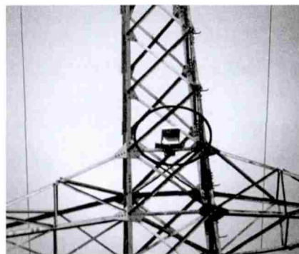
图6 智能超声驱鸟装置现场安装照片
