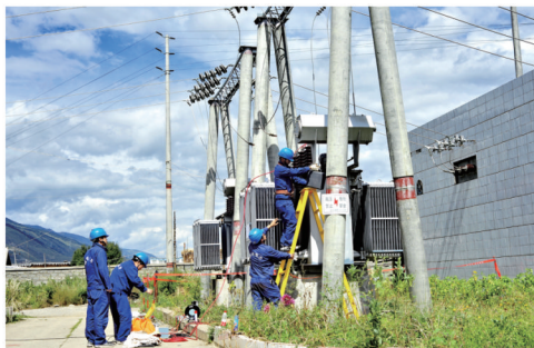
对县级电力配网设备进行电气试验
