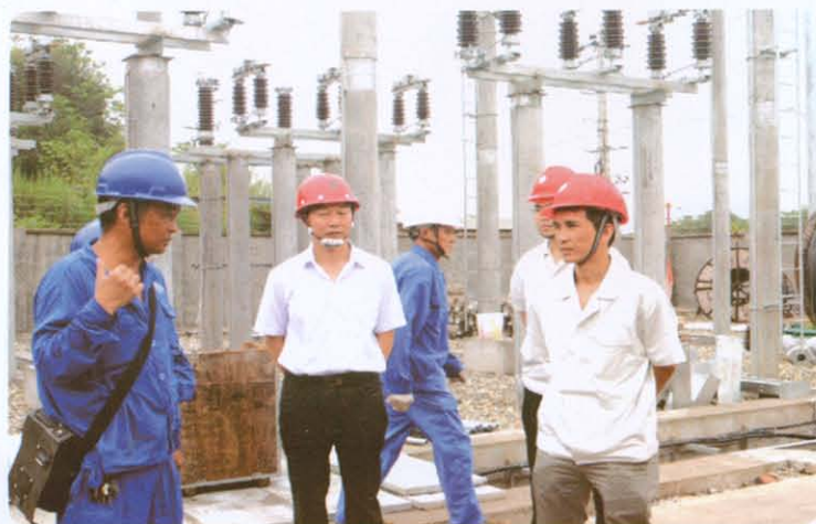
◆ 总经理陈强督察变电站工程建设
