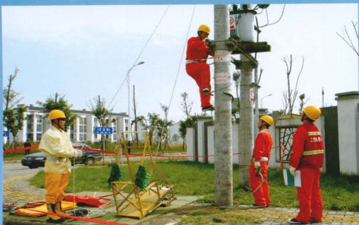
德阳电力员工在汉旺新镇开展带电作业
