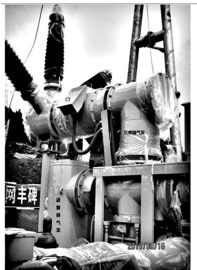
图 1 GIS 出线间隔实物图
