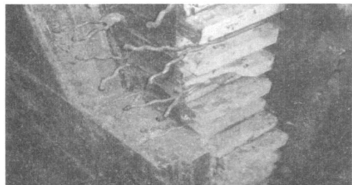
图 3 外置床耐火材料结构
