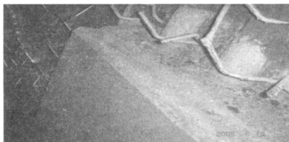
图 2 炉膛耐火材料结构
