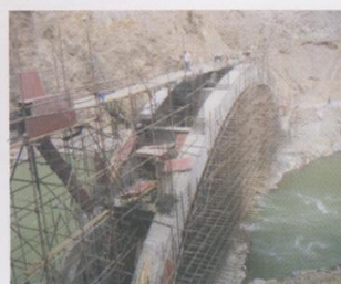
跨水洛河5号桥施工
