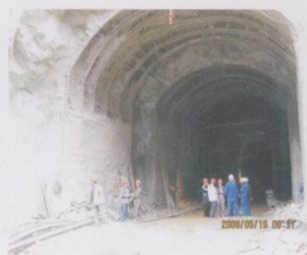
宁朗电站3号支洞施工
