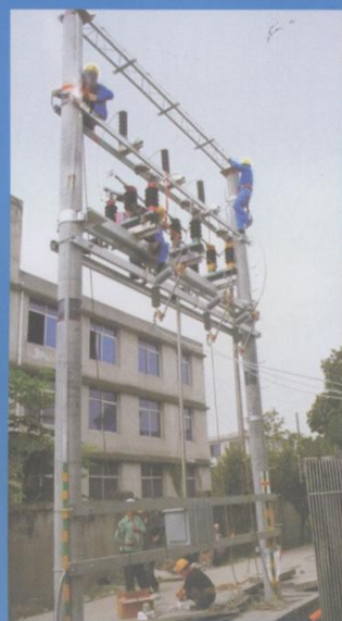
抗震救灾中抢修35kV中兴变电站
