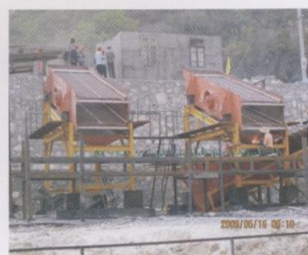
宁朗电站砂石料场设备安装
