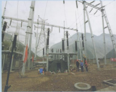
二台山变电站施工现场
