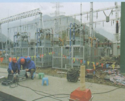
四川电力试验研究院高电压技术中心在对设备进行调试
