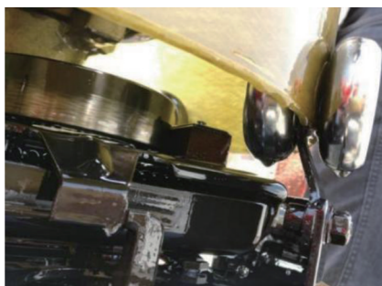
(a) 正常固定的紧固均压螺栓
