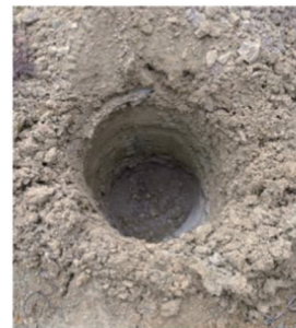
(c) 施工桩孔的质量
