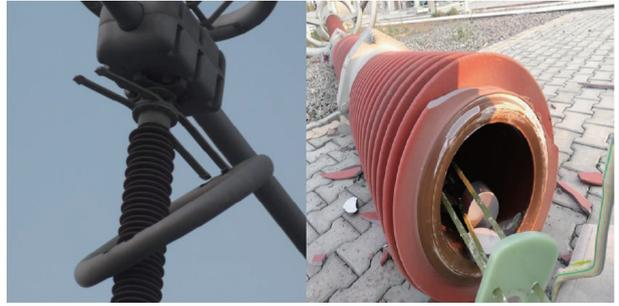
图 1 大风地区变电站支柱类设备破坏案例
