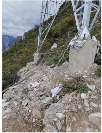
图2 施工弃土堆载诱发滑坡
