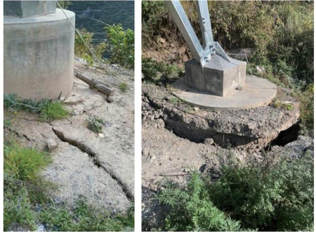
图 5 基础周围土体裂缝和脱离
