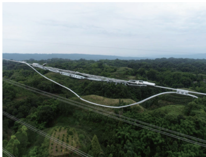
图 6 光缆修补后现场
