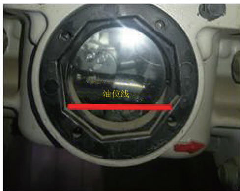
图 1 瓦斯内部存在大量气体
