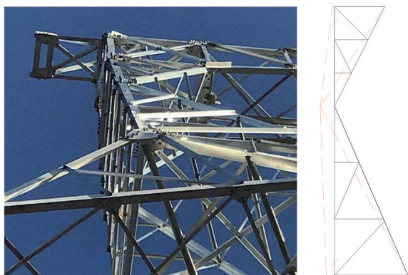
图2 曲臂K节点变形实例及示意图
