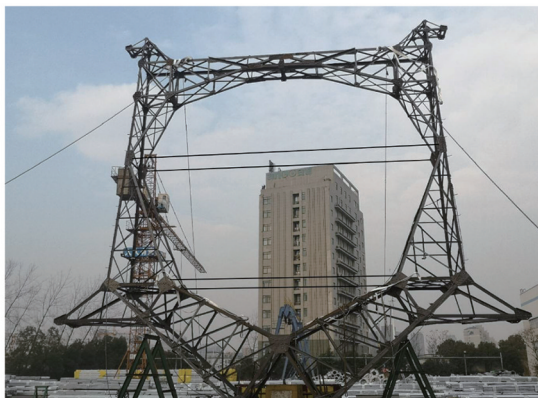
图 15 猫头塔立式试组装现场
