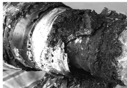
图 3 击穿点附近的电缆焊接情况
