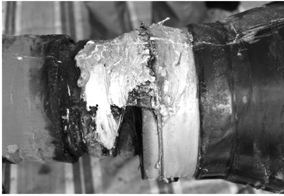
图4 非击穿侧的电缆焊接情况
