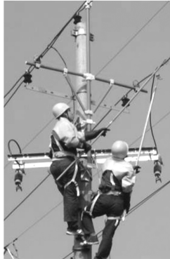
图12 实际作业现场
