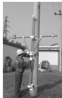
图11 地面练习安装
