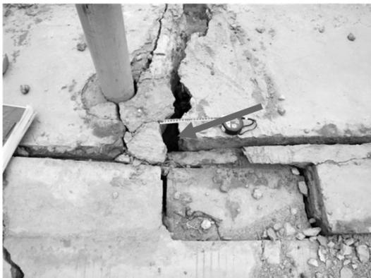
图2 基础开裂
