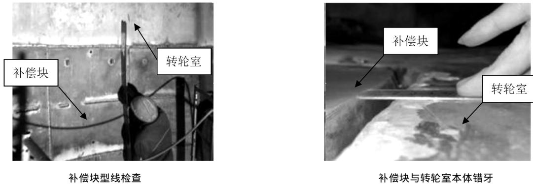
图3 转轮室模块化消缺技术应用
