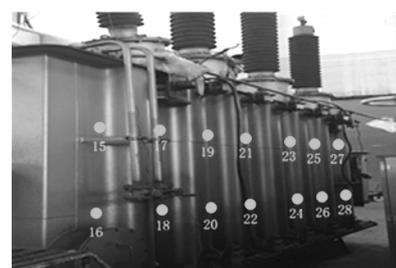
图 4 变压器的测点分布
