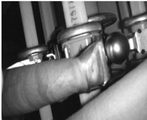
图4 分接开关动静触头
