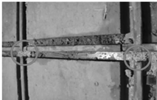
图2 变压器运输轨道结构
