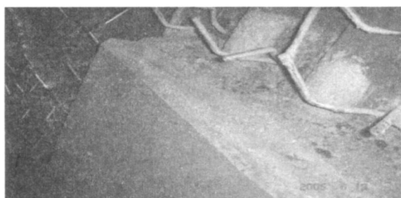
图 2 炉膛耐火材料结构
