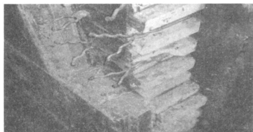
图 3 外置床耐火材料结构
